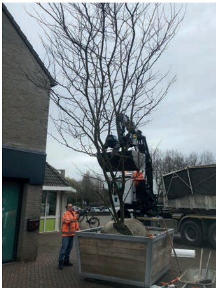
Plaatsen van de boombakken
